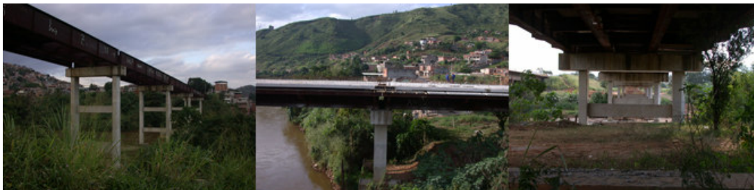
FIGURA 03 – Imagens de infraestruturas viárias (viadutos) em construção no novo trecho do anel rodoviário da BR-381 em Coronel Fabriciano.
